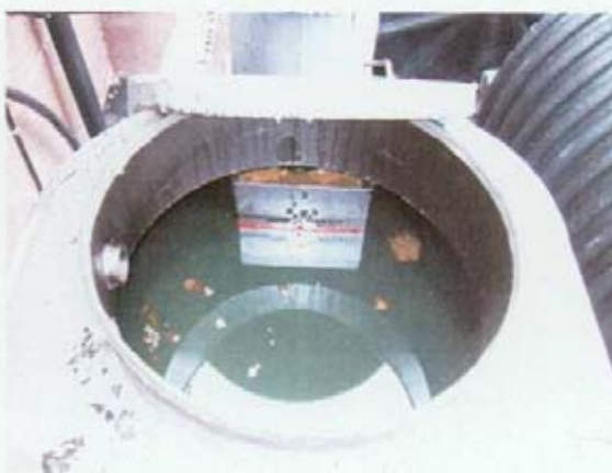
Fig. 2 Fri fase flåte i oljeavskillerdelen.
