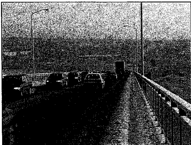
Bildet viser Fredrikstadbrua en helt vanlig vinterdag. På denne veistrekingen passerer det flere biler hvert døgn enn over Svinesund. Biler som kjører oppoverbakke slipper i tillegg ut opp mot 150 prosent mer nitrogenoksider enn ved kjøring på en flat vei.
