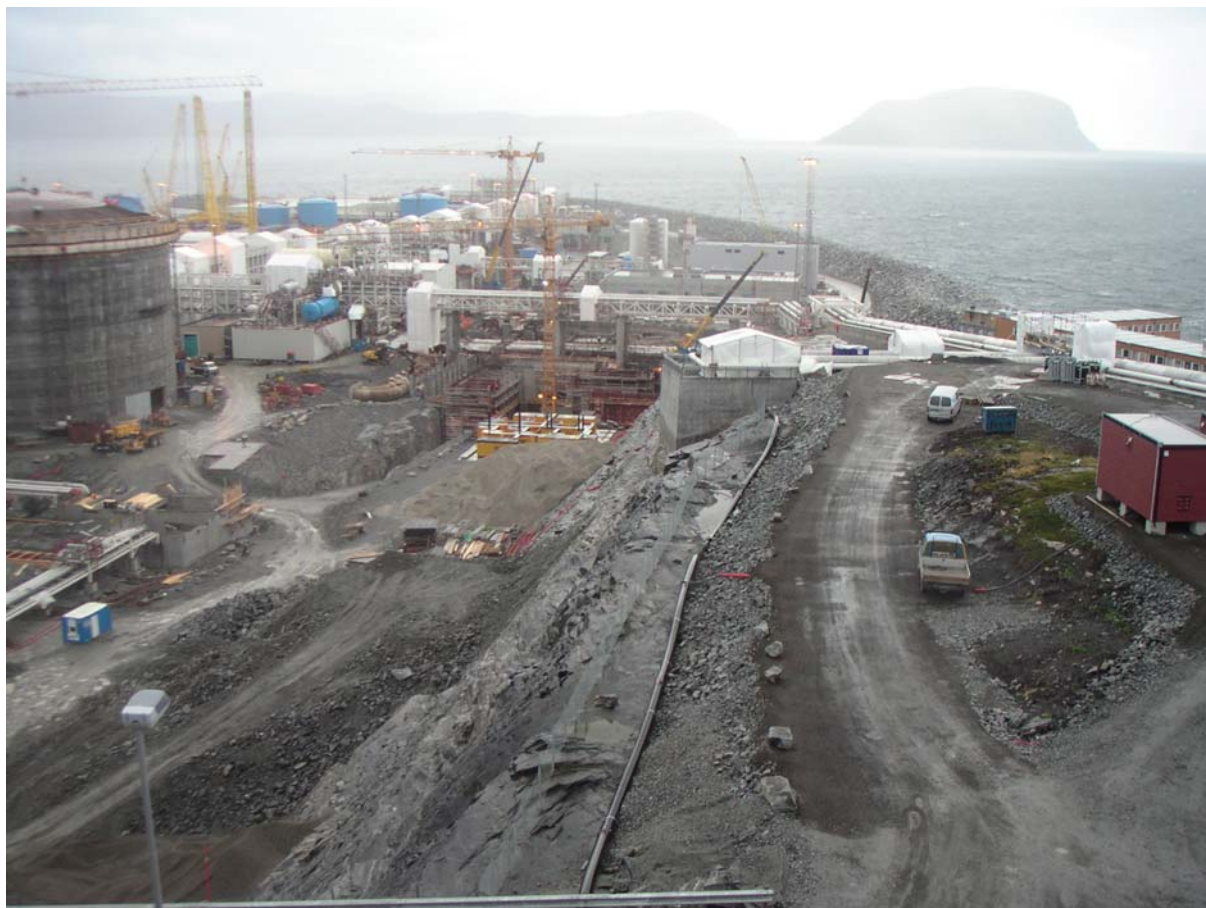
Figur 10.2 Anleggsarbeider på Melkøya sept 2004.
