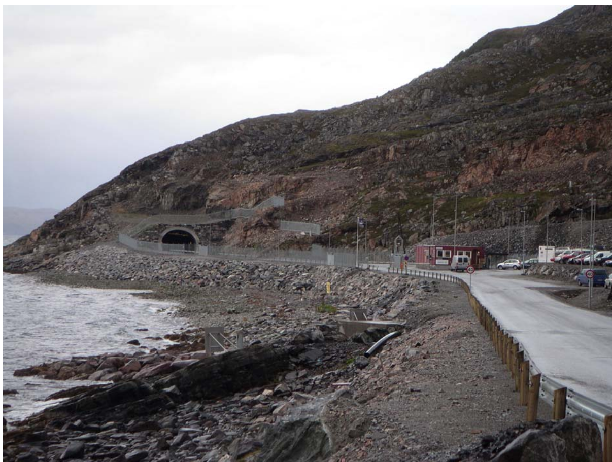
Figur 10.9 Statoils tunnelinnslag mot Melkøya ved Meland med adgangskontroll. Bildet er tatt fra svingen ved planlagt tomt for Hammerfest Gasskraftverk ved Rossmolla.
