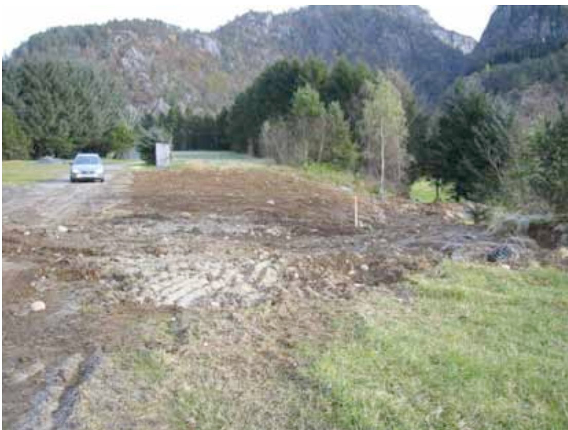
Figur 2. Tidlegare Suldal planteskule 23.10.03. Deponiområdet og ny vegtrase sett mot aust etter påføring av vekstlag. Deponiet ligg i nivå med jordet bak og har slak skråning mot nyvegen.
