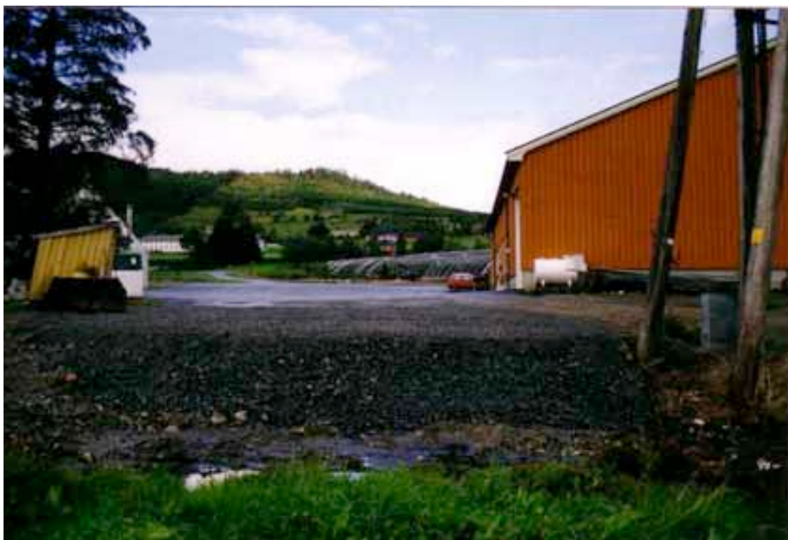
Figur 2. Megarden Planteskule 23.09.03. Det tidlegare deponiområdet etter massefjerning og tilført ny berelagsmasse.
