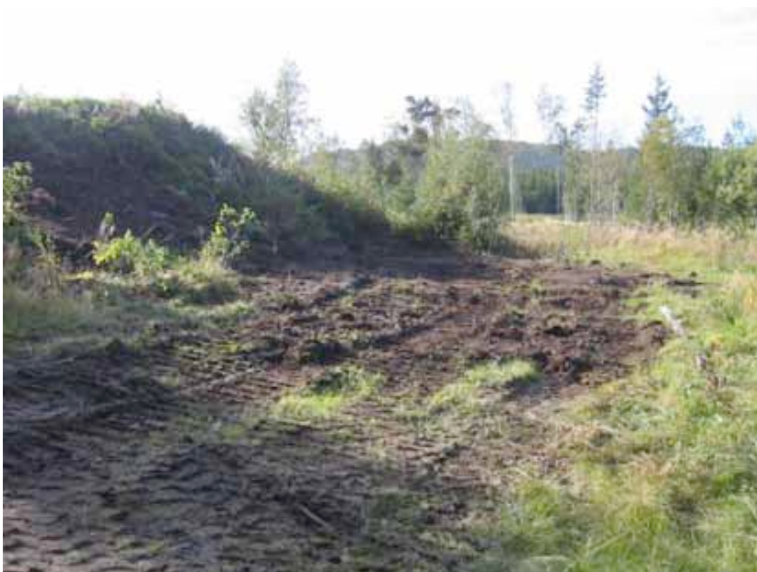
Figur 2. Kvatningen Planteskole 10.09.03. Deponiområdet etter massefjerning og tilbakefylling med rein masse.
