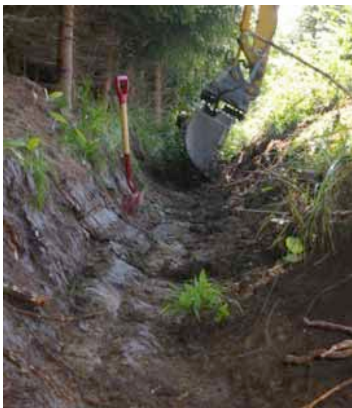
Figur 1. Brustad Planteskole 27.08.03. Grøftereinsk av forureina sediment i den opne grøfta med avrenning frå frilandsområdet.
