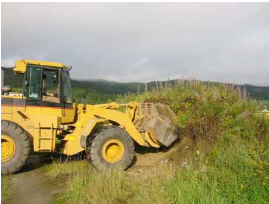
Figur 1. Tidlegare Muan Planteskole 18.08.03. Opplasting av jordhaug med DDT-restar i samanskrapa masse frå veksthusområdet.
