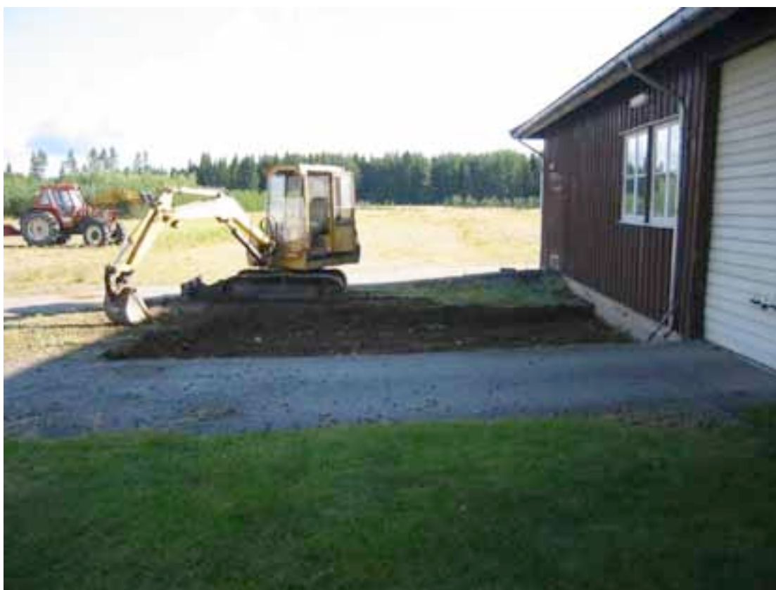
Figur 1. Tidlegare Furusmo planteskole 15.08.03. Massefjerning frå behandlingsstaden.
