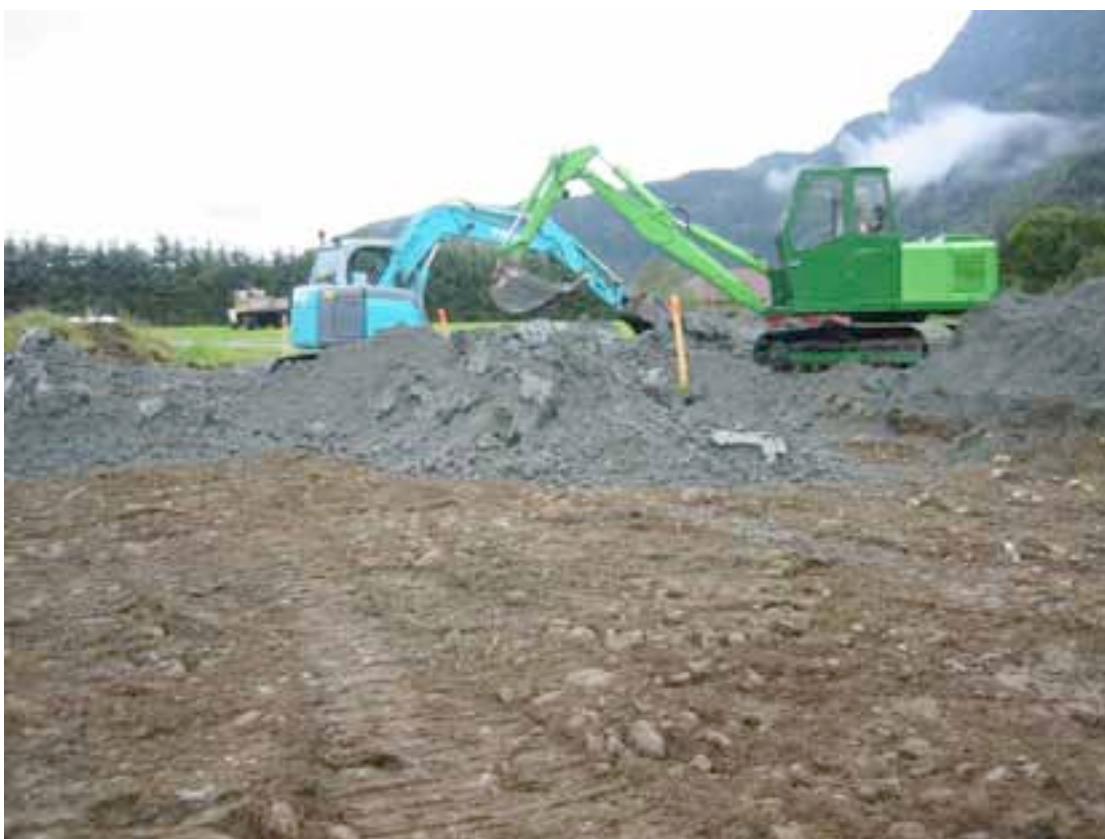
Figur 1. Tidlegare Suldal planteskule 17.09.03. Deponiområdet under tildekking etter arrondering av deponioverflata.
