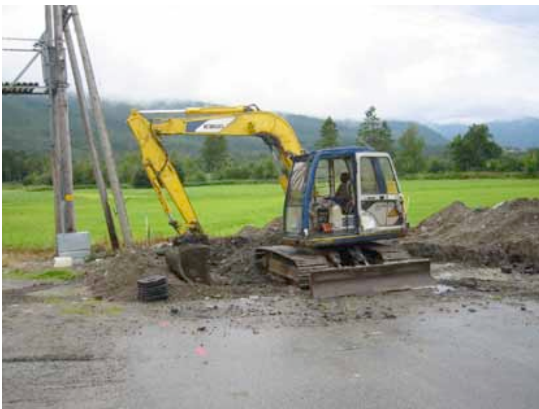
Figur 1. Megarden Planteskule 19.08.03. Fjerning av deponimasse på kanten mot dyrkamarka.
