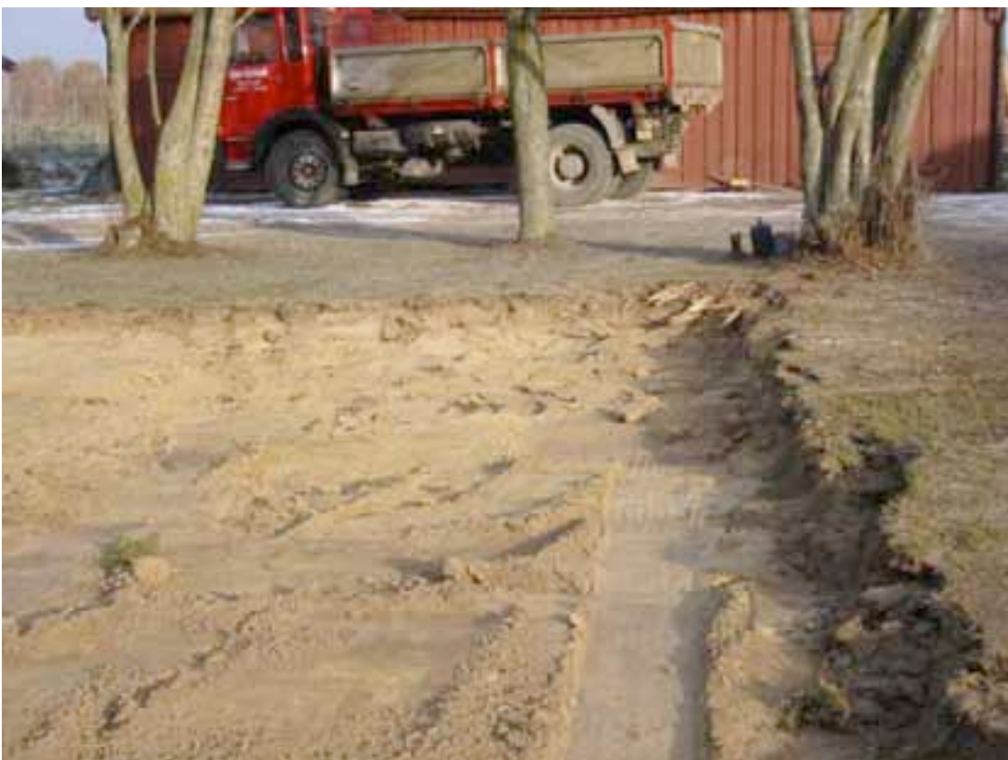
Figur 2. Tidlegare Skulstadmo Planteskole 24.10.03. Massefjerning frå behandlingsstaden med finsand til mellomssand under torv.
