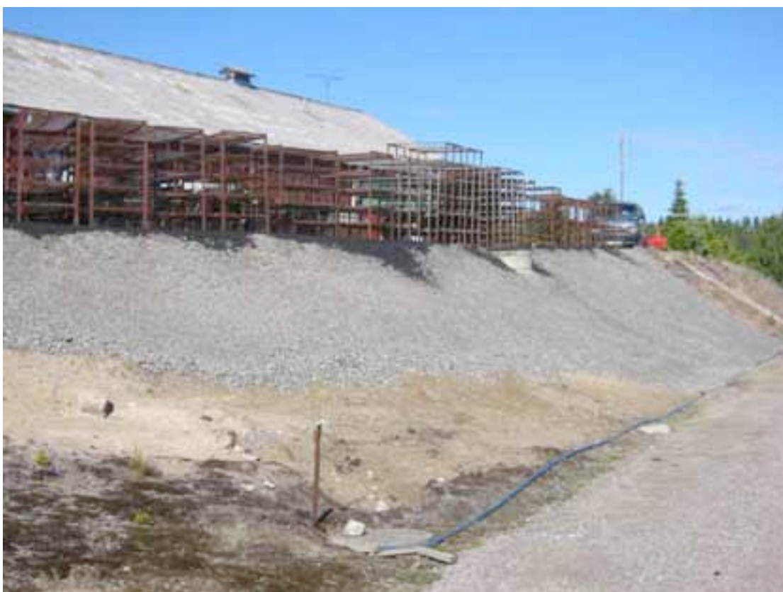
Figur 2. Prestebakke planteskole 27.05.04. Deponiområdet etter avslutta tiltak. Ny, stabil masse er påført i skråninga og oppstillingsarealet er reasfaltert.
