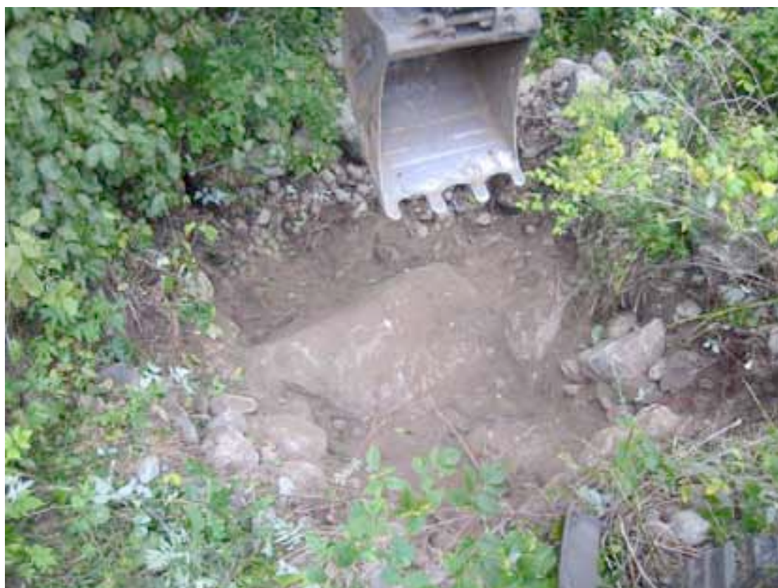
Figur 2. Benningstad Planteskole 02.09.03. Massefjerning til storblokk på ca. 1 m djup frå deponiområdet i steinfylling.
