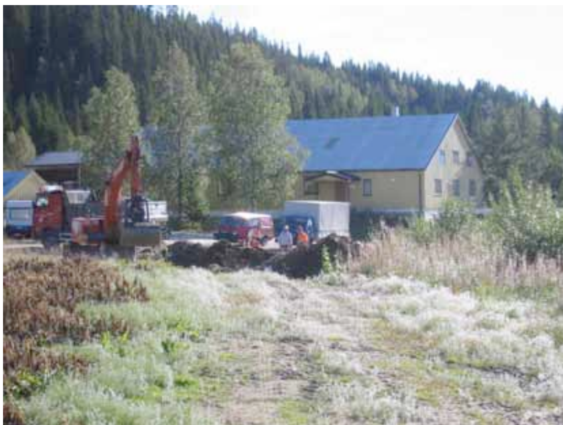
Figur 2. Tidlegare Skogstad planteskole 11.09.03. Deponiområde B. DDT-slam deponert mellom annan avfallsmasse på fyllingskanten mot E6. Massane er overdekte med rein jord og grus.
