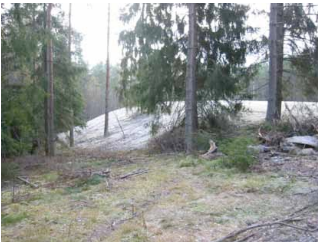
Figur 1. Sønsterud Planteskole AS 24.10.03. Austre deponiskråning etter ferdig tildekking av avfallsfyllinga.
