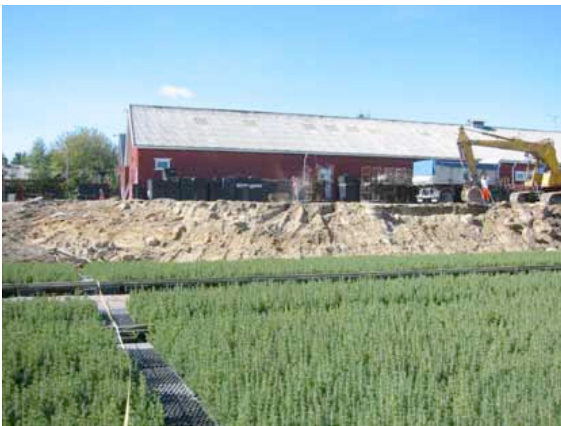
Figur 1. Prestebakke planteskole 28.08.03. Massefjerning fra deponiområdet i skråninga nedanfor driftsbygningane.
