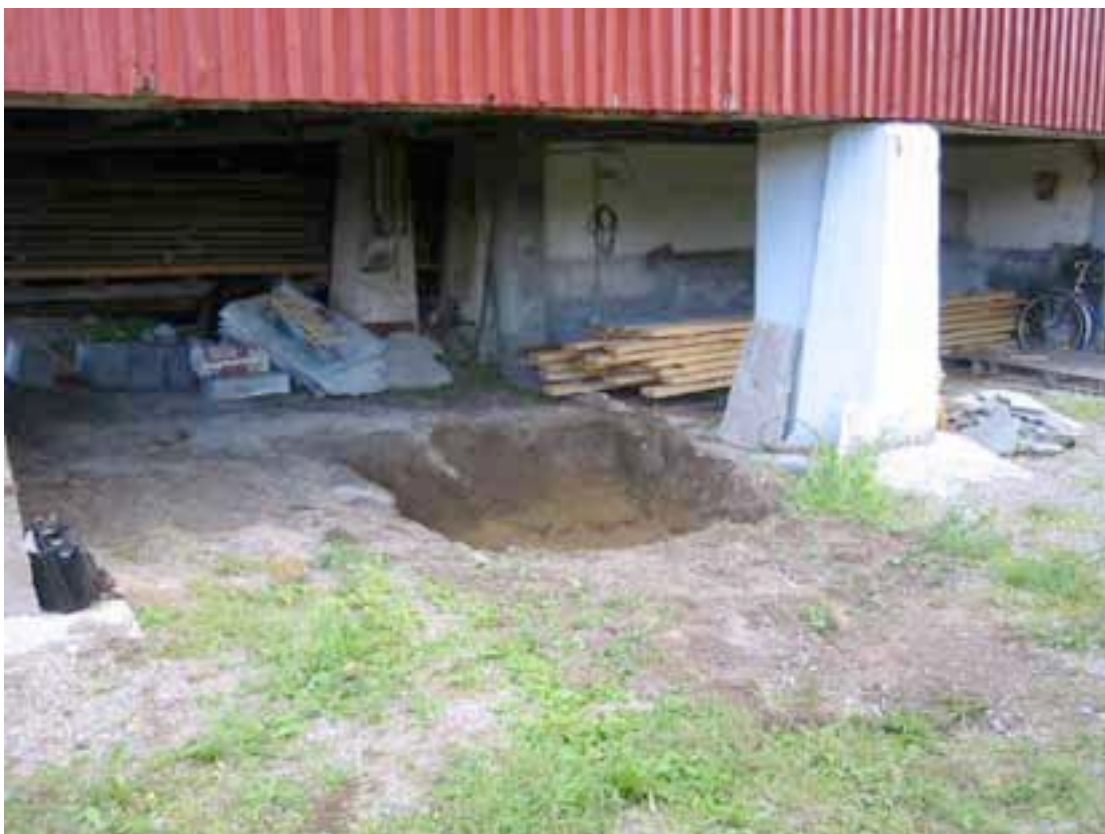
Figur 2. Granli Planteskole 12.08.03. Massefjerning frå behandlingsstaden under låven.
