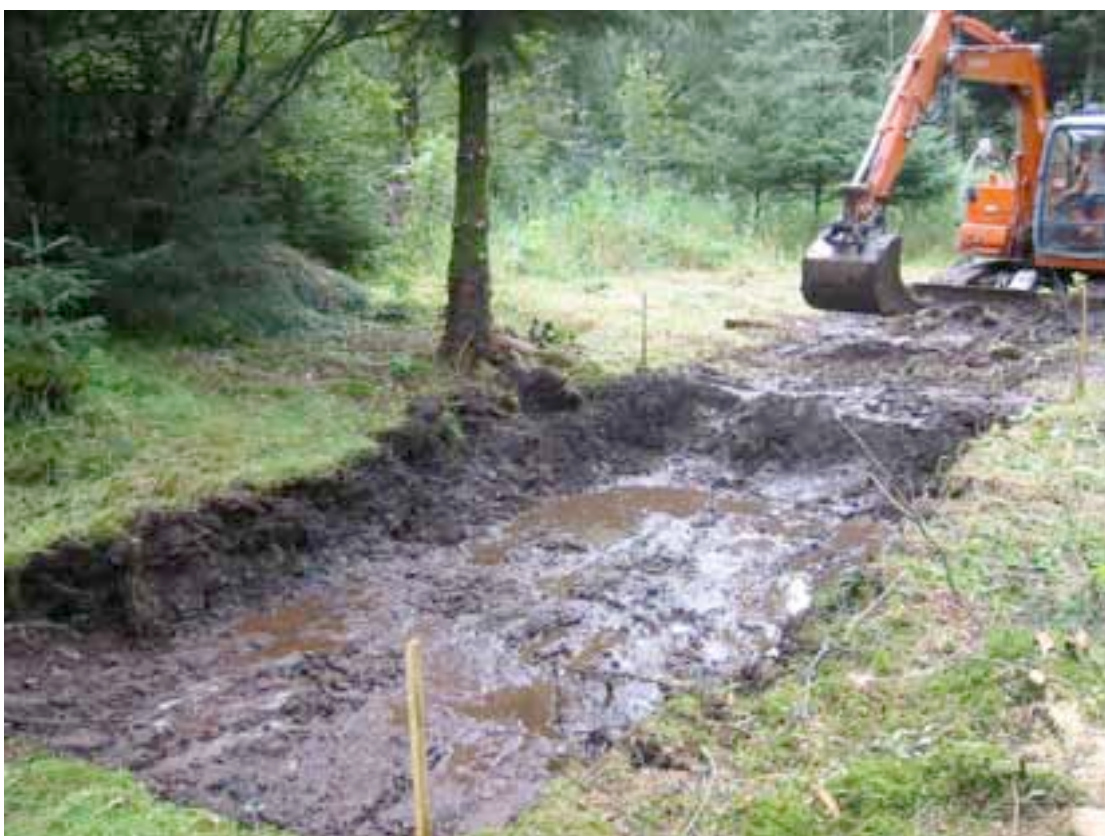
Figur 2. Brandsøy Planteskule 05.08.03. Fjerning av DDT-deponiet og omkringliggende myrjord til fjell (sett mot sør).
