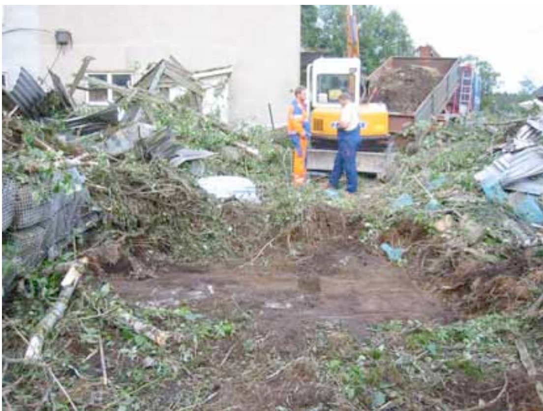
Figur 2. Tidlegare Kråketorp planteskole 21.08.03. Fjerning av deponert masse mellom revebura.
