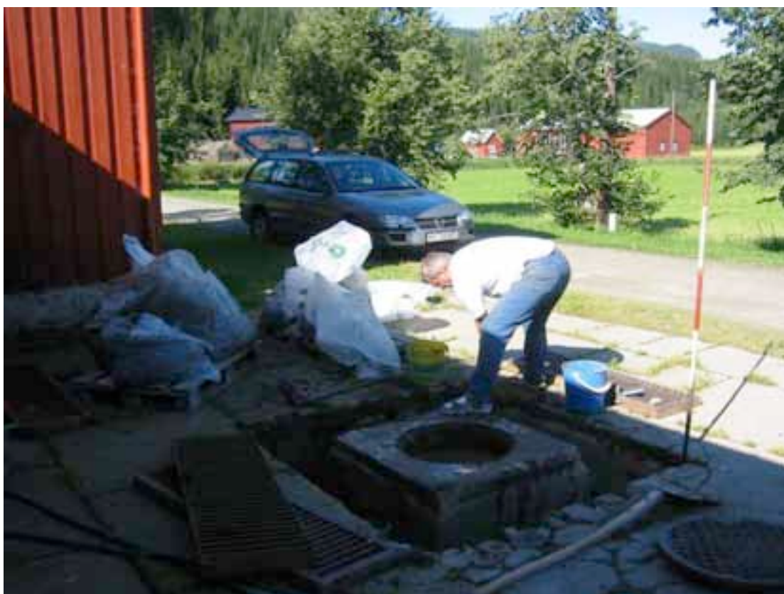
Figur 2. Tidlegare Muan Planteskole 18.08.03. Mekanisk tømming av sandfanget. Slamsuging vart utført i indre kum.
