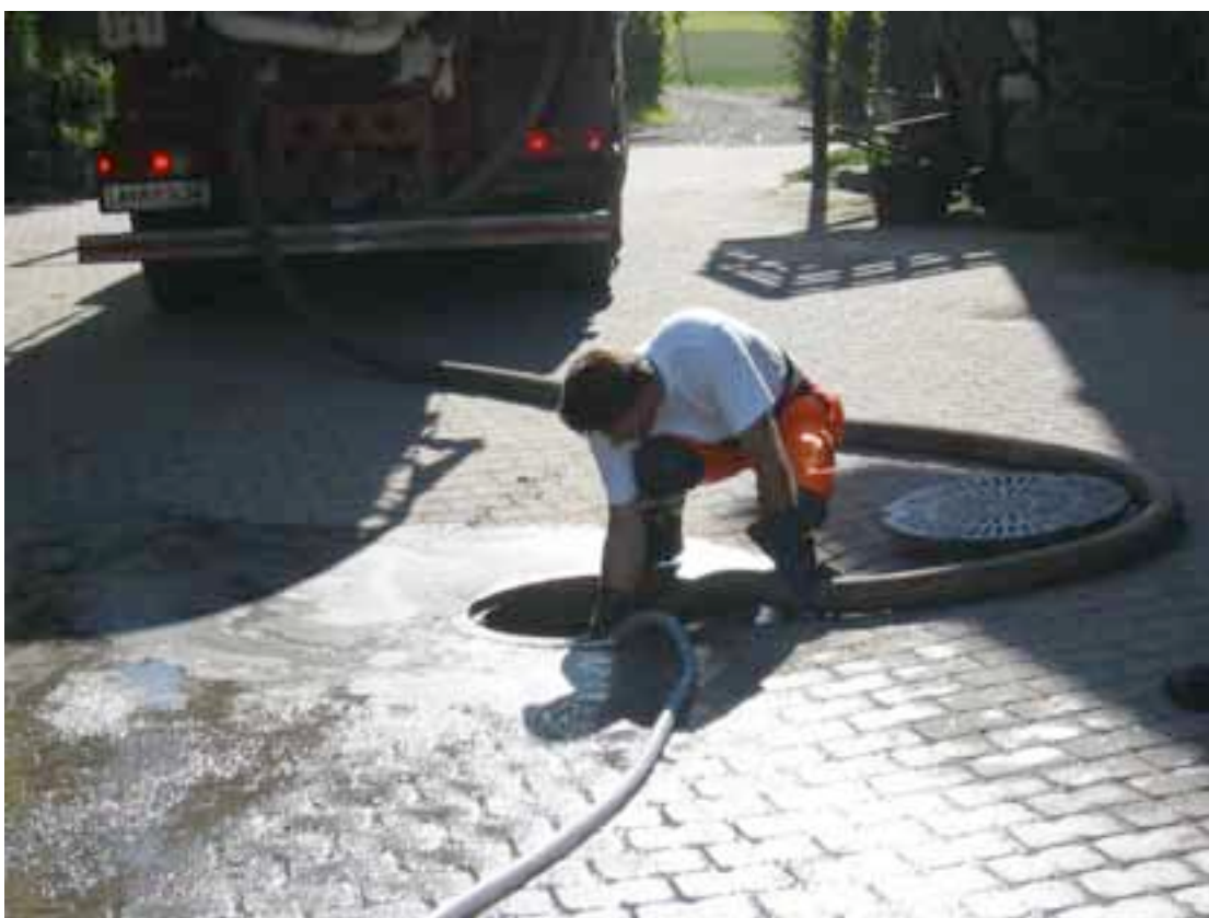
Figur 1. Tidlegare Fritzøe Planteskole, Jordet Brunlanes 08.07.03. Tømming av kum på behandlingsstaden.
