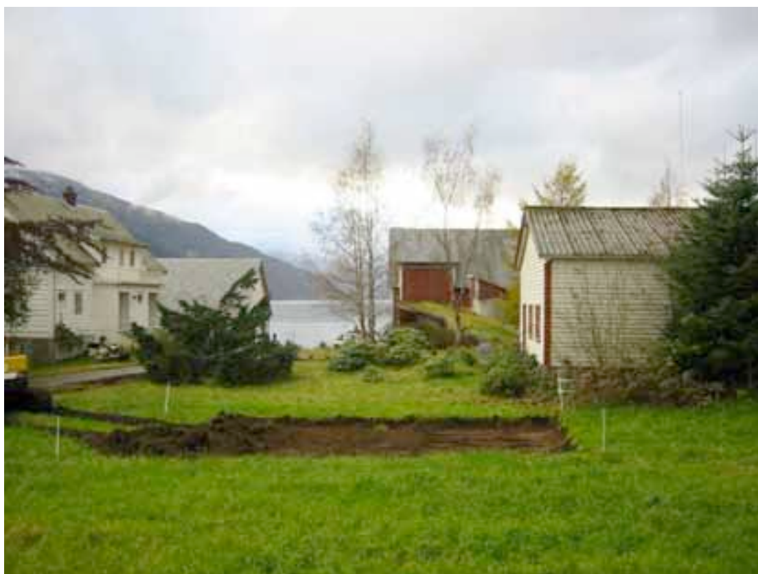
Figur 2. Tidlegare Sørland Planteskule 27.10.03. Massefjerning frå området for tippe DDT-slam.
