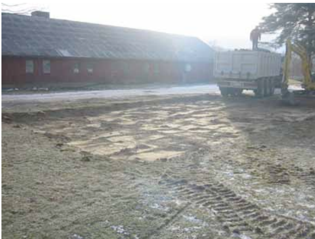
Figur 1. Tidlegare Skulstadmo Planteskole 24.10.03. Massefjerning frå behandlingsstaden inne i tunet.
