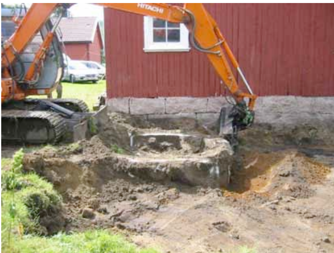
Figur 1. Tidlegare Fritzøe planteskole, Akerholt 08.07.03. Massefjerning frå behandlingsstaden med gamalt fundament for silo.
