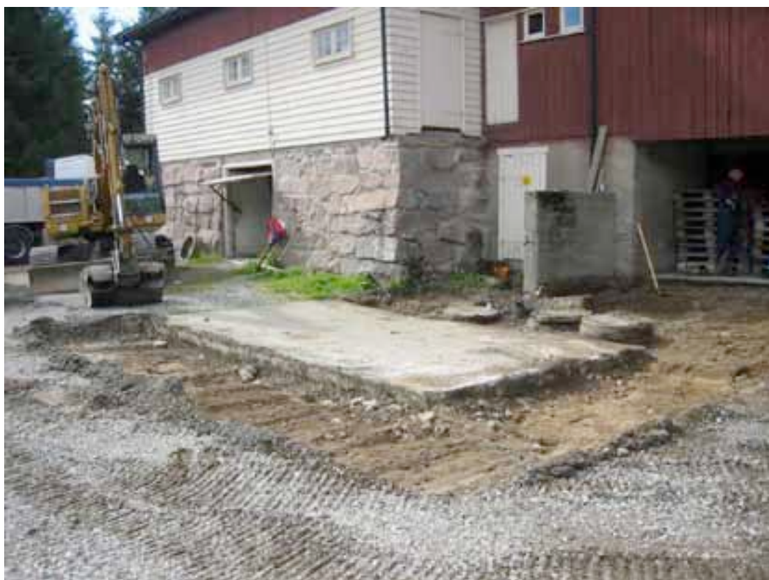
Figur 2. Brustad Planteskole 27.08.03. Massefjerning på behandlingsstaden under og framanfor låve. Betongplata vart liggande. Kummane i bakkant vart tømt.
