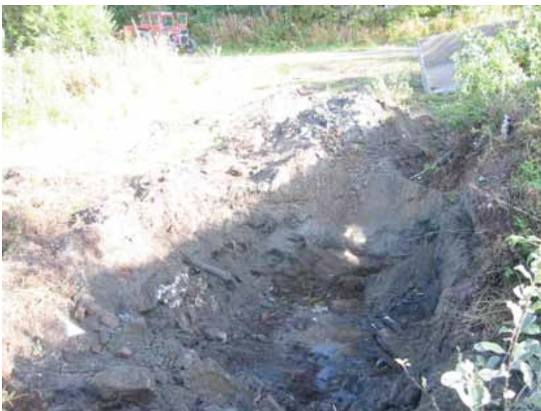
Figur 1. Kvatningen Planteskole 10.09.03. Fjerning av deponiet med DDT-slam og annan avfallsmasse til ned i naturleg siltjord og torv/myr.
