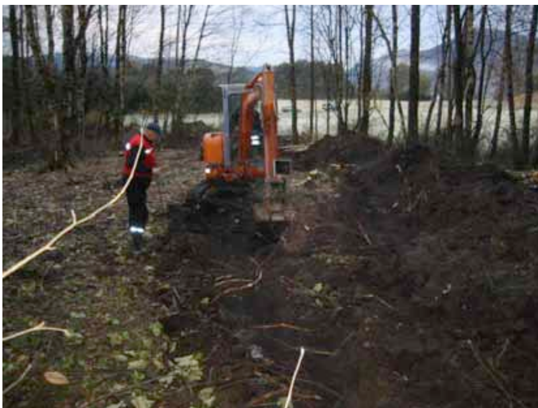
Figur 2. Tidlegare Etne Planteskole 23.10.03. Sjaktgraving i Drømmelunden for søk etter deponert DDT-slam.
