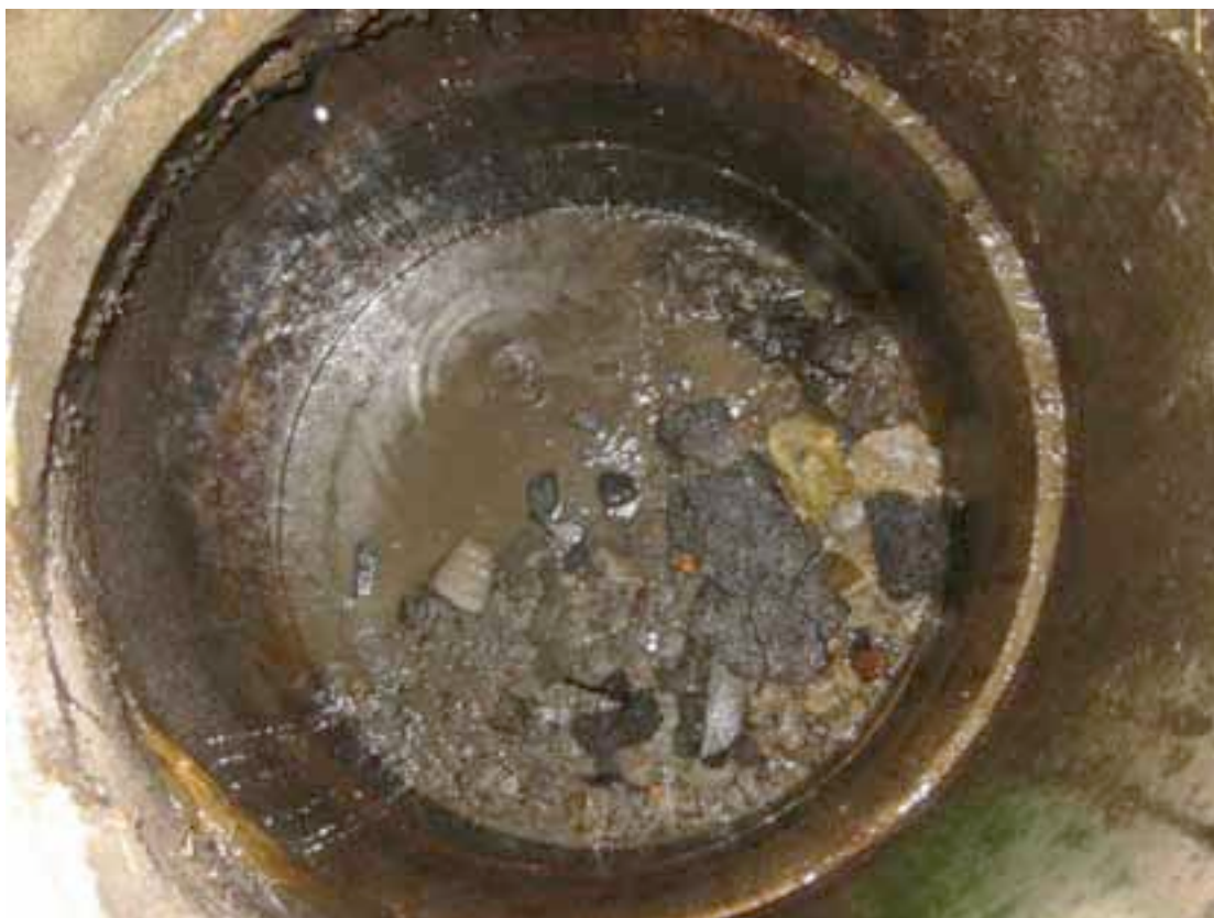
Figur 2. Tidlegare Fritzøe Planteskole, Jordet Brunlanes 08.07.03. Kum på behandlingsstaden etter spyling og slamsuging.
