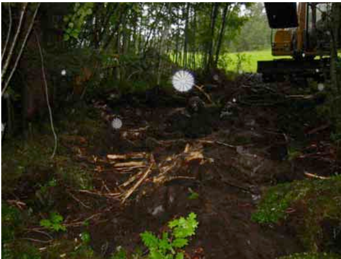
Figur 1. Tidlegare Vøy planteskule 20.08.03. Fjerning av DDT-deponiet i utmark.
