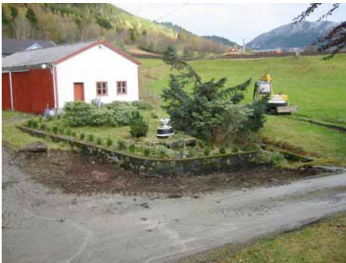
Figur 1. Tidlegare Sørland Planteskule 27.10.03. Massefjerning frå området for behandling og mellombels lagring av behandla planter for avrenning av overskotsvæske.
