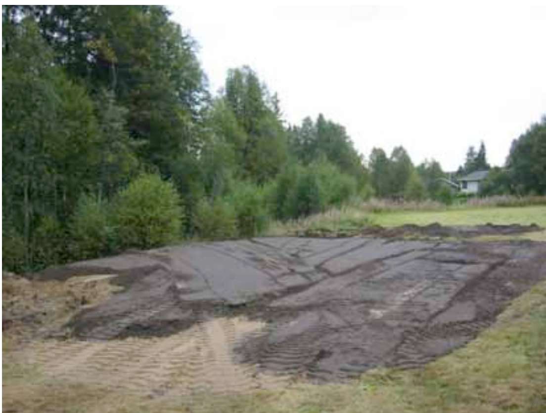
Figur 2. Trysil Planteskole AS, Smestadjordet 04.09.03. Påføring av vekstlag etter utlagt tildekkingsmasse.
