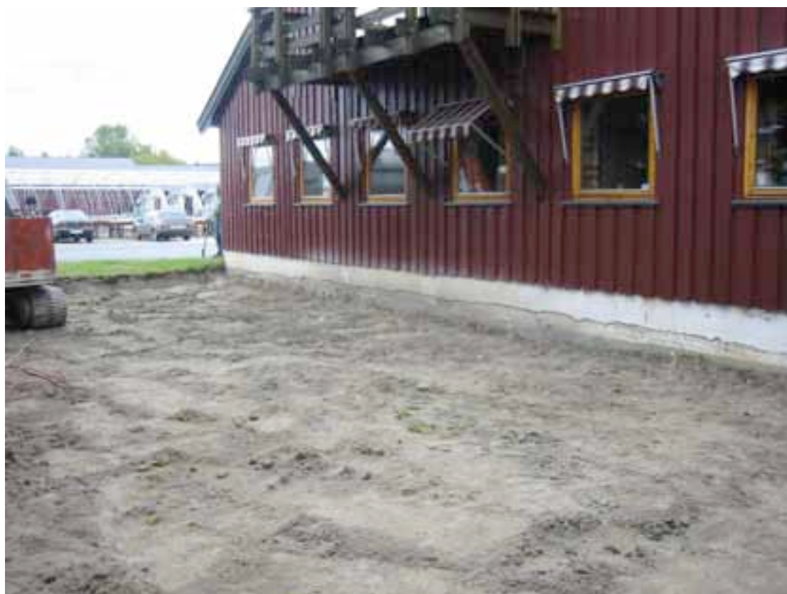
Figur 2. Buskerud Skogselskaps Planteskole 26.08.03. Massefjerning frå deponi 1 ved enden av kontorbygget.
