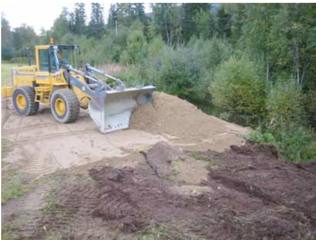
Figur 1. Trysil Planteskole AS, Smestadjordet 04.09.03. Utlegging av tildekkingsmasse etter arrondering av deponioverflata.
