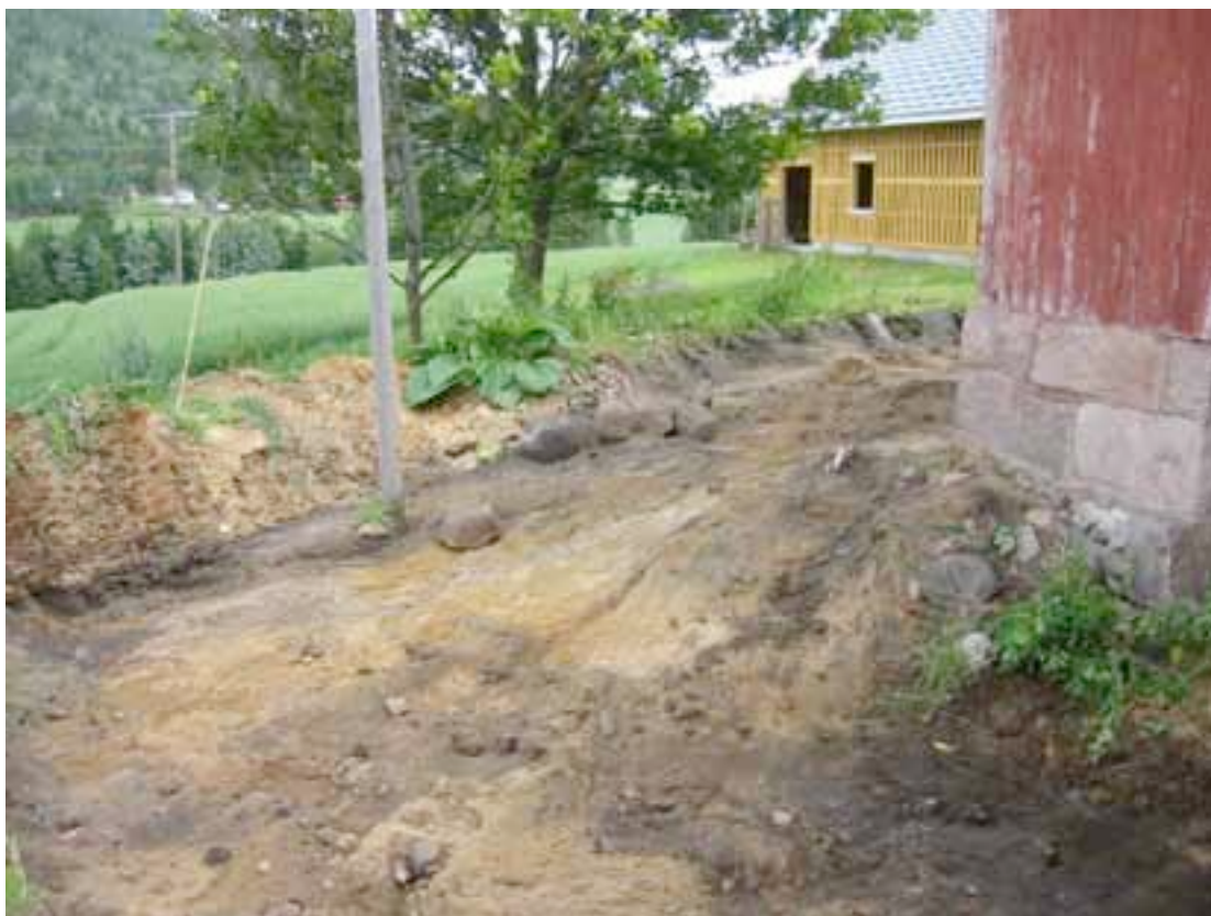
Figur 2. Tidlegare Fritzøe planteskole, Akerholt 08.07.03. Massefjerning frå behandlingsstaden og nedanfor låven, der det òg truleg hadde blitt deponert DDT-slam.
