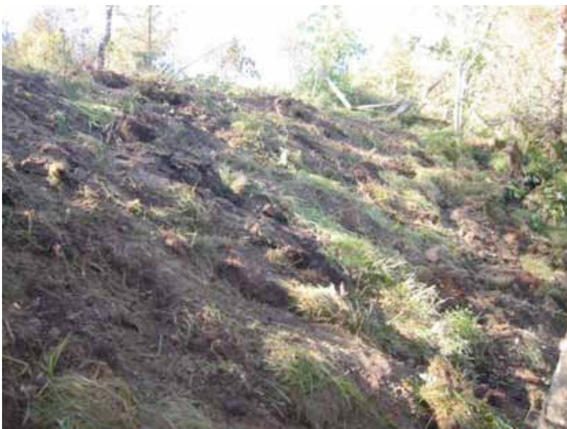
Figur 2. Lyngdal planteskole, Vindskaret 16.09.03. Ferdig tildekt deponi med utlagt torv som erosjonsvern og for rask reetablering av vegetasjon.
