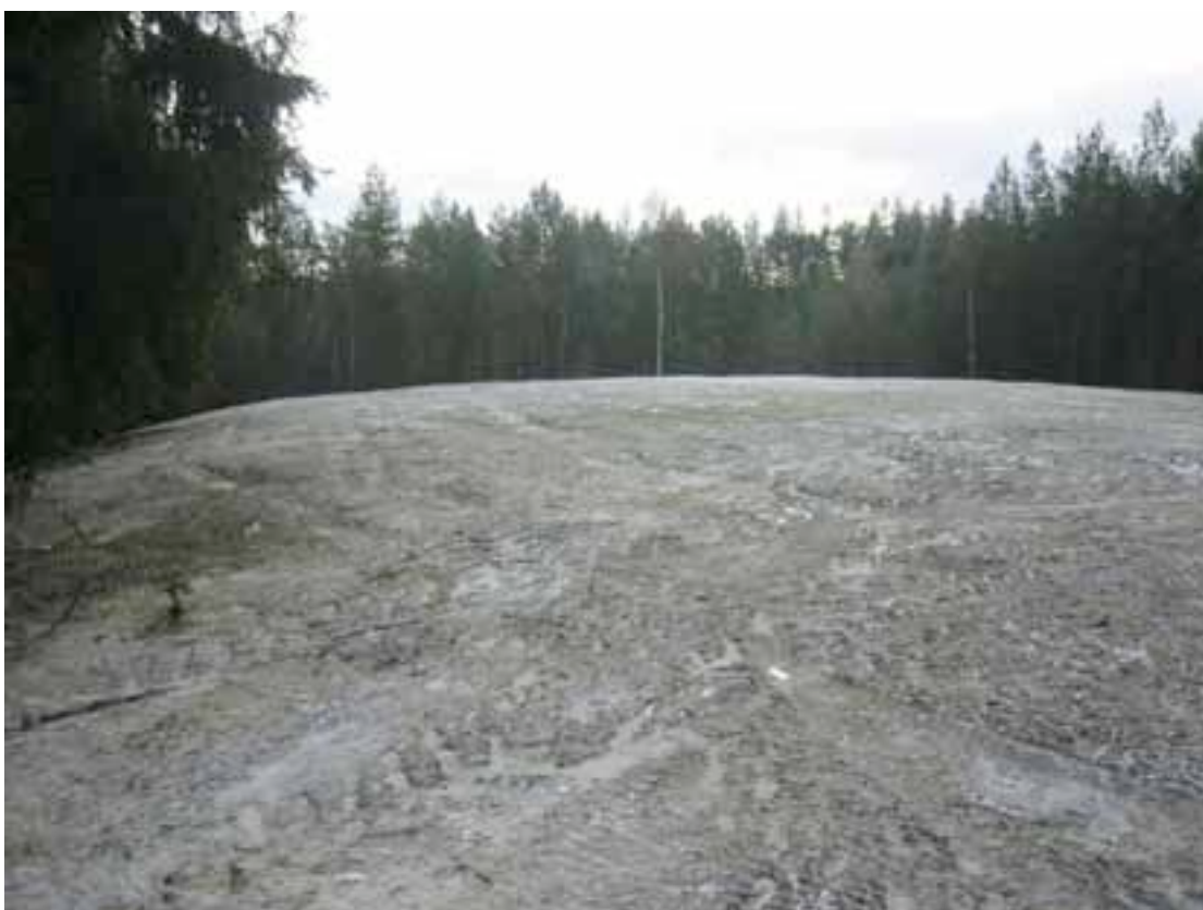
Figur 2. Sønsterud Planteskole AS 24.10.03. Deponiflata etter ferdig tildekking av avfallsfyllinga med arrondering for avrenning av overflatevatn. Overflata er tilsådd.
