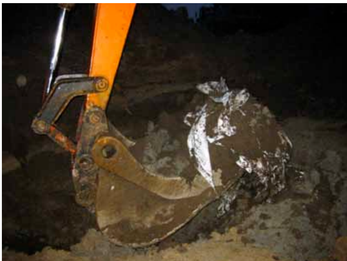
Figur 2. Tidlegare Torp Skogplanteskule 30.10.03. Deponert DDT-slam emballert i plast under oppgraving frå deponiet lagt i leire ved kontorbygget.
