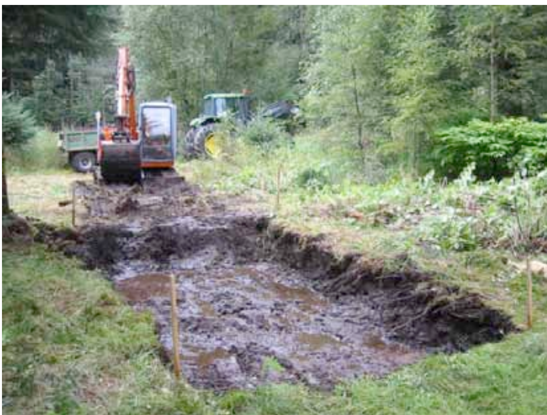
Figur 1. Brandsøy Planteskule 05.08.03. Fjerning av DDT-deponiet og omkringliggende myrjord til fjell.
