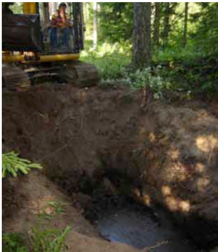
Figur 1. Granli Planteskole 12.08.03. Oppgraving av deponimasse og organisk avfall frå deponigropa.
