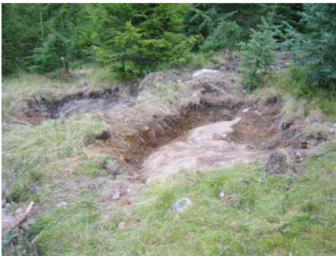
Figur 1. Tidlegare Midtskogen planteskole 02.09.03. Massefjerning i deponiområdet. DDT-slam var lagt ut på to stader. Massen vart fjerna til fjell.
