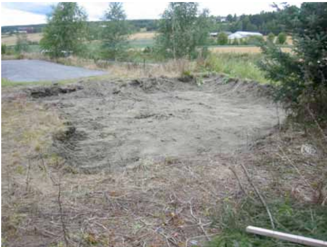
Figur 1. Buskerud Skogselskaps Planteskole 26.08.03. Massefjerning frå deponi 2 langs bakkekammen mot riksvegen.
