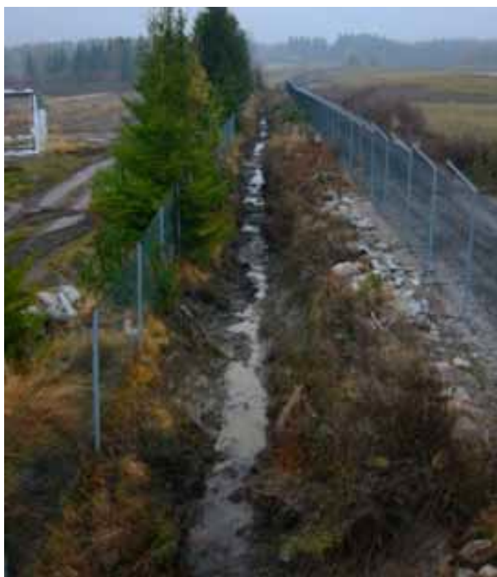
Figur 1. Tidlegare Torp Skogplanteskule 30.10.03. Grøftereinsk med fjerning av forureina sediment i kanalen mot Sandefjord lufthamn.
