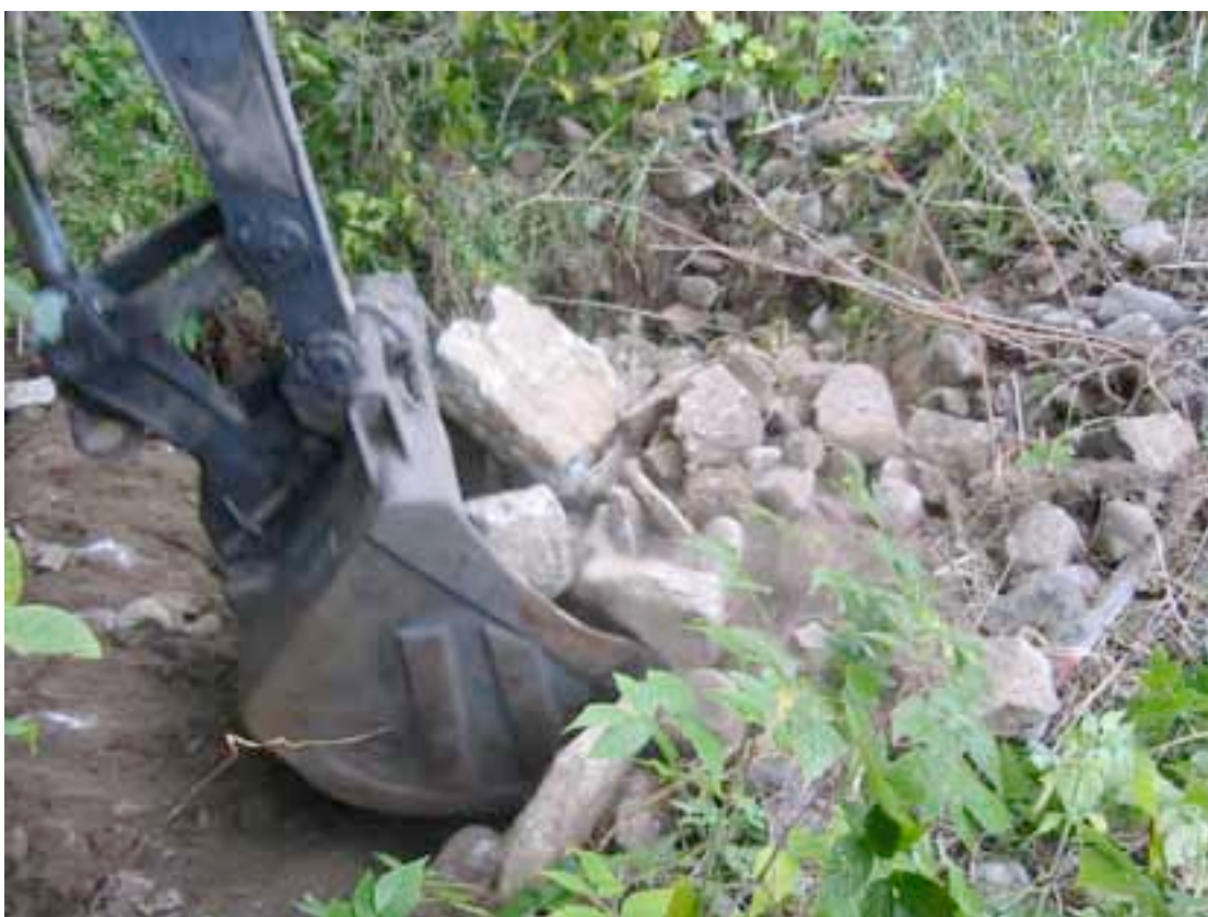
Figur 1. Benningstad Planteskole 02.09.03. Massefjerning frå deponiområdet i steinfylling. Grovstein vart fråsortert.
