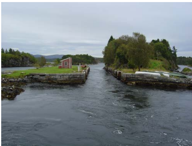
Slusen i utløpet av Lindåspollene i Nordhordland (sluseportene er fjernet for reparasjon).
