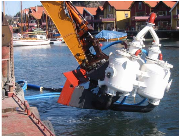
Figur 6 Pneumapumpe som er nyttet i forbindelse med mudringen i Kamfjordkilen
