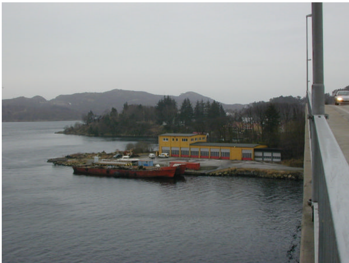
Figur 12: Fotografi av Rotterdam nedlagt avfallsfylling, tatt fra bybroa i retning vestover, i 2002.
