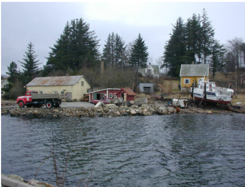
Figur 11: Fotografier av slippen på Engøy, tatt i 2002. Bildene er tatt fra Gåseholmen i retning nord-øst.
