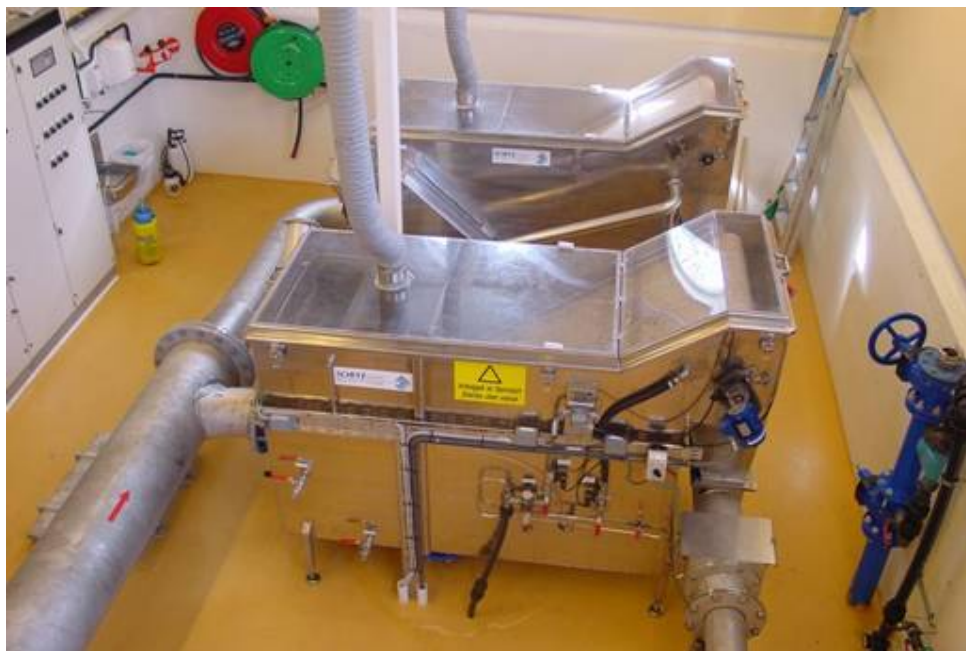
Fig. 5. Skjærvika renseanlegg med to silmaskiner av typen Soby Miljøfilter.
