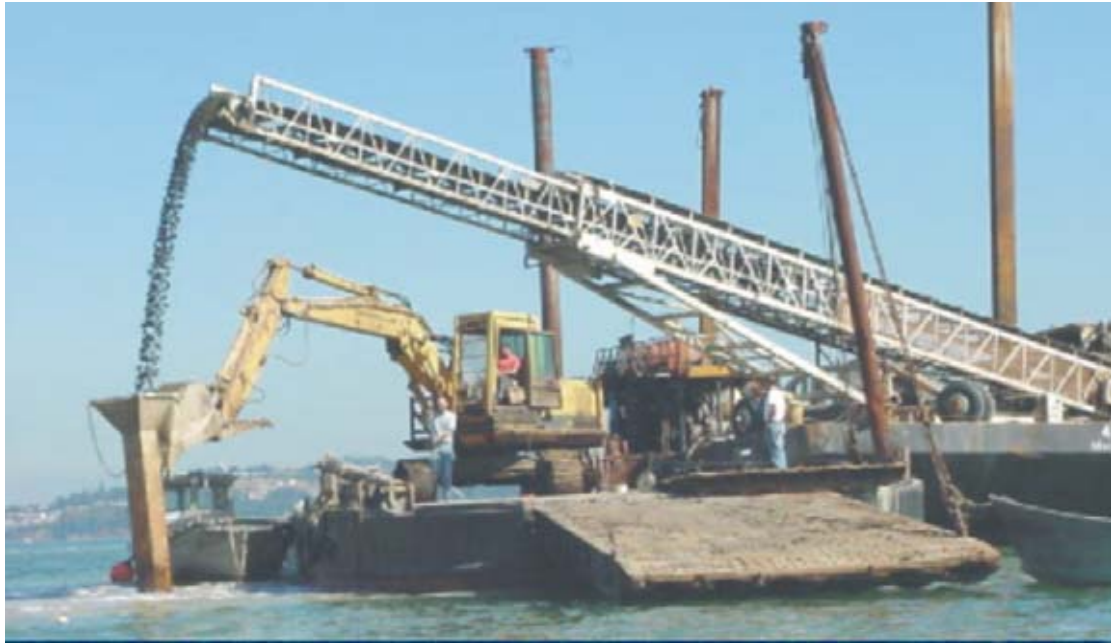
Fig.3. Utlegging av tildekkingsmateriale på forurensset sjøbunn via senketrakt.
