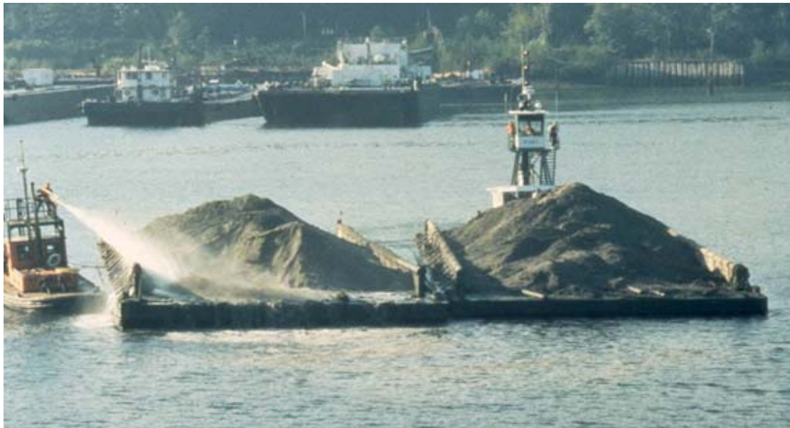
Fig.4. Tildekkingsmaterialet spyles fra lekter ut i sjøen og sedimenterer fritt til bunnen.
