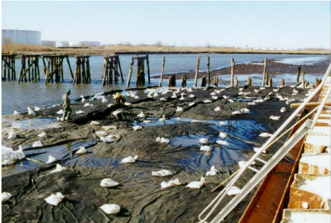
Fig.1. Bruk av geotekstiler i forbindelse med tildekking elvededimentar ved lav vannføring.
