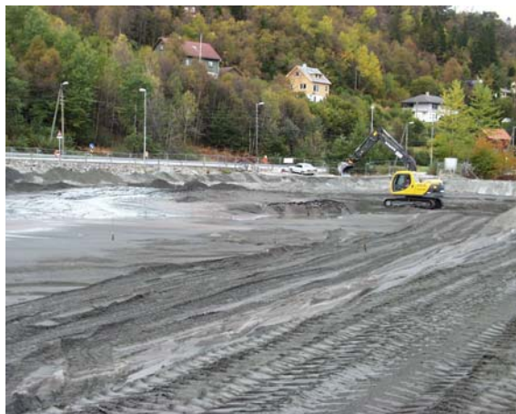
Foto 3 Tildekking av deponiet
