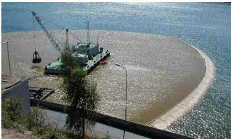
Fig.1. Bruk av siltskjørt under mudring i Kristiansandsfjorden (kilde: erfaringsnotat fra Pilotprosjekt for opprydding i forurensede sedimenter i Kristiansandsfjorden”.
