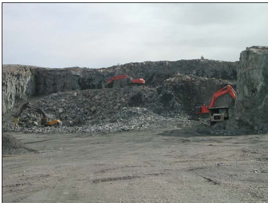
Figur 4: Foto fra arbeidet med utsparingen i steinbruddets sørlige grense. Utsparingen vil inneholde Ytre lager og inngangen til deponianlegget.
