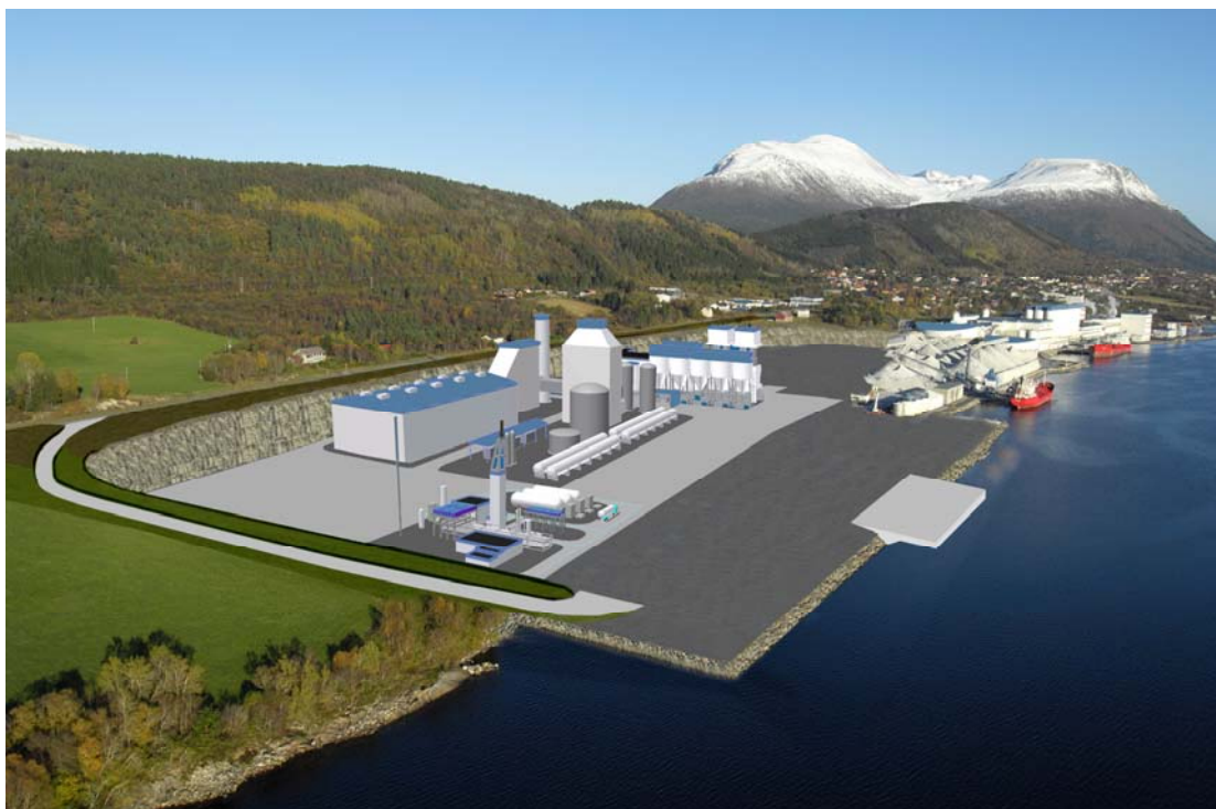
Figur 12-1: Bilde illustrerer industrikraftverket, CO2-fangstanlegg, PCC-fabrikk og LNG-fabrikk på det planlagte området
