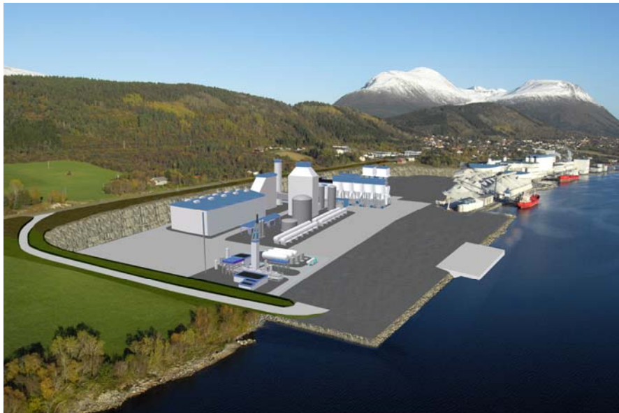
Figur 4-1: Bilde illustrerer industrikraftverket, CO2-fangstanlegg, PCC-fabrikk og LNG-fabrikk på det planlagte området
