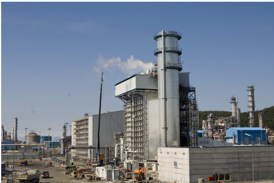
Figur 2: Gasskraftverk under bygging på Kårstø (Kilde: Naturkraft AS)
