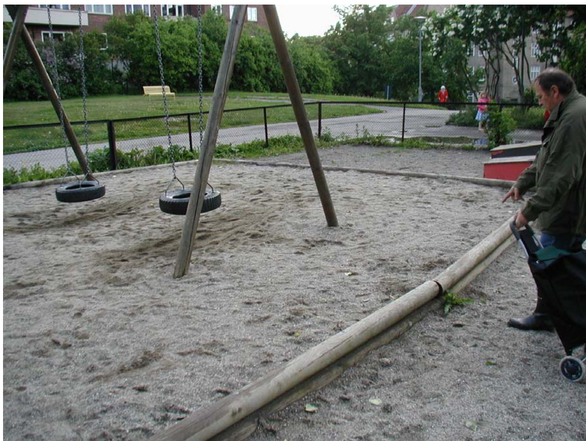
Figur 11 Til avgrensning av dette sandbassenget har det vært brukt CCA-impregnerte rundstokker.
