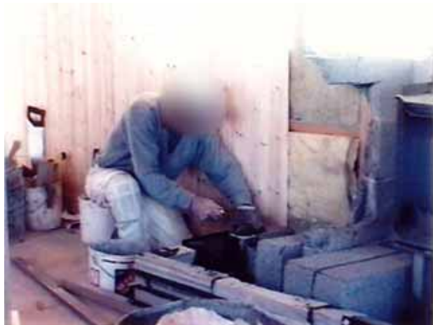
Figur 16 Mureren dekker til med mørtel.
