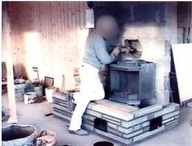
Figur 19 Mureren jevner til hullet for ovnsrøret med meisel og hammer.
