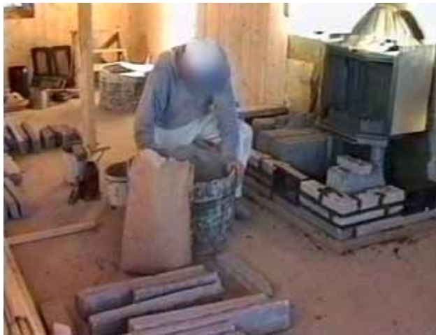
Figur 18 Røring, sett forfra.
