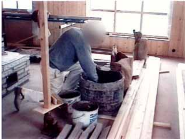
Figur 17 Røring i mørtelbaljen, sett fra siden.
