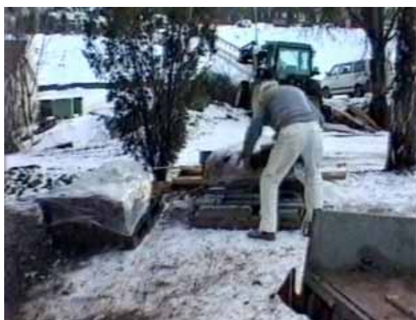
Figur 12 Mureren er i ferd med å løfte skiferbølge.
