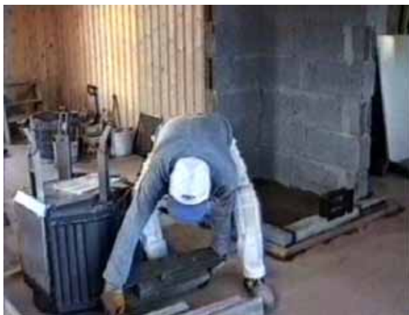
Figur 14 Mureren velter forsiktig skiferen over på siden og ned på gulvet.
