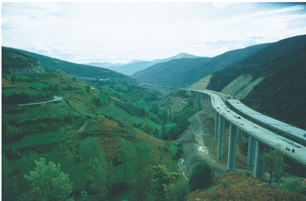
Bilde 6: Motorvegen fra La Coruña til Madrid under bygging.
