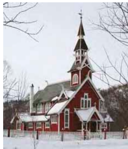
Neiden kirke i Sør-Varanger er sterkt preget av stavkirkenes pittoreske former med avtrapping opp gjennom etasjene. Bygningen er ellers rikt dekorert med mange varianter av fabeldyr og masker. Foto: Arkitektur i Nord-Norge/Jens Christian Eldal.
