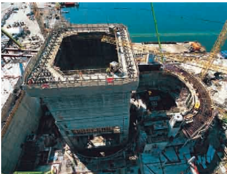
Bygging av operaen i Oslo, foto: Veidekke
