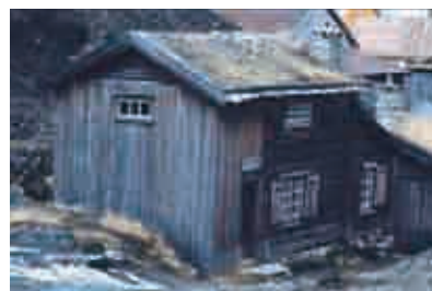
Persstugu Røros, fredet i 1922. Kilde: Rørosmuseet.
