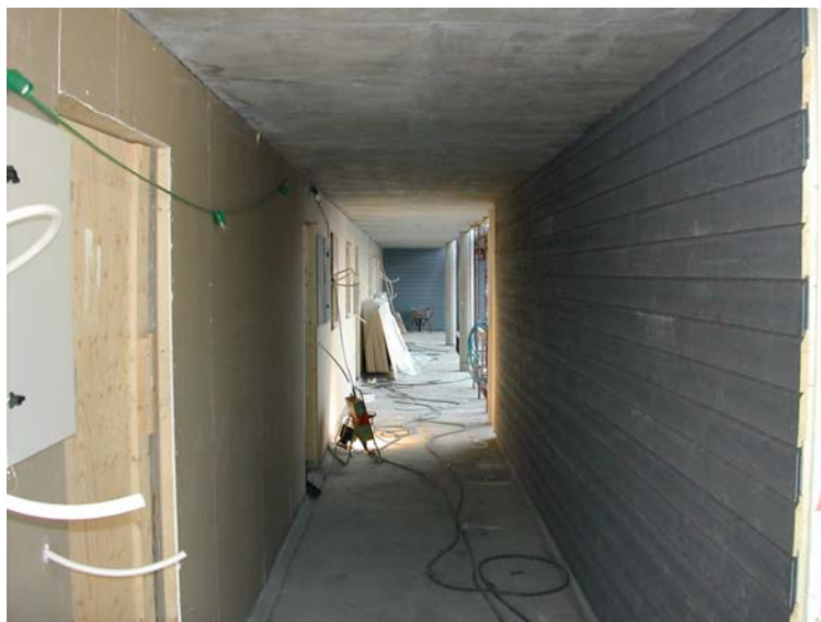
Bilde 1 Eksempel på innbygging av deler av svalgang.
