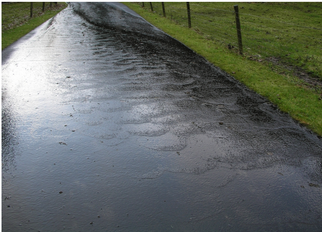
Figur 4: Roll waves på en asfaltvei under regnvær (Bildet har blitt kopiert fra http://www.maths.ox.ac.uk/~fowler/pictures/gallery.html ).
