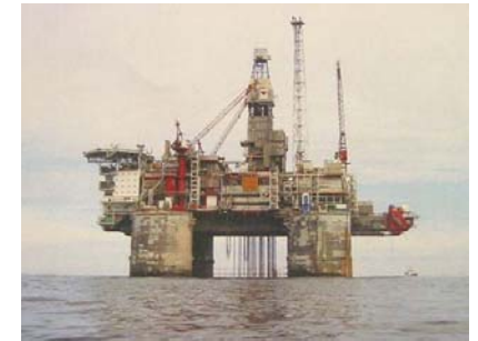
Heidrun - en flytende plattform i betong forankret med strekkstag
